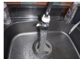
シャワー型蛇口の設置
