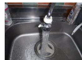
シャワー型蛇口の設置
